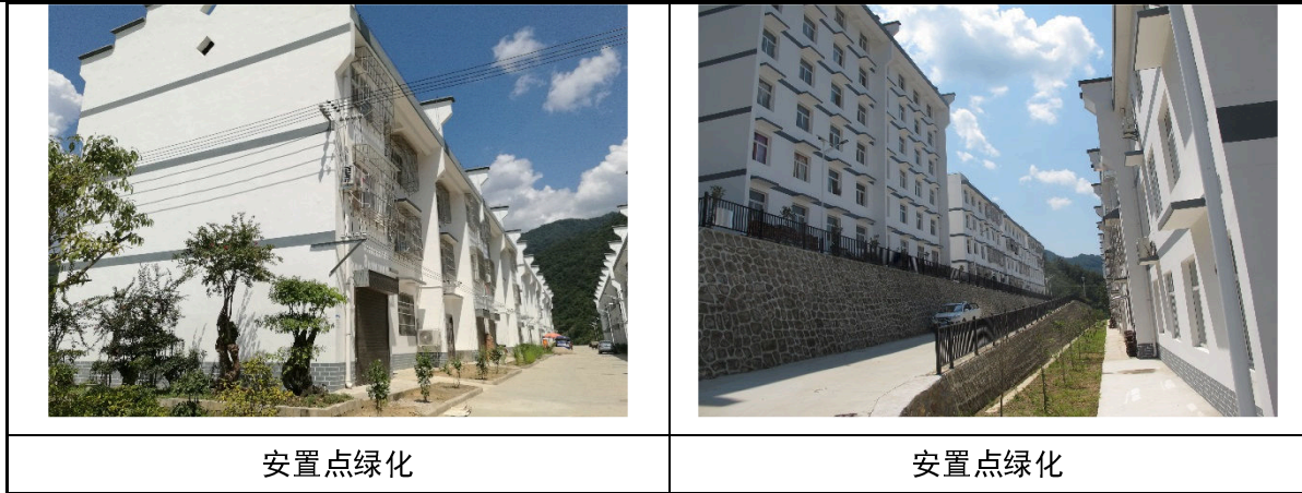
图 5.4-6 干田梁安置点环保措施落实照片
