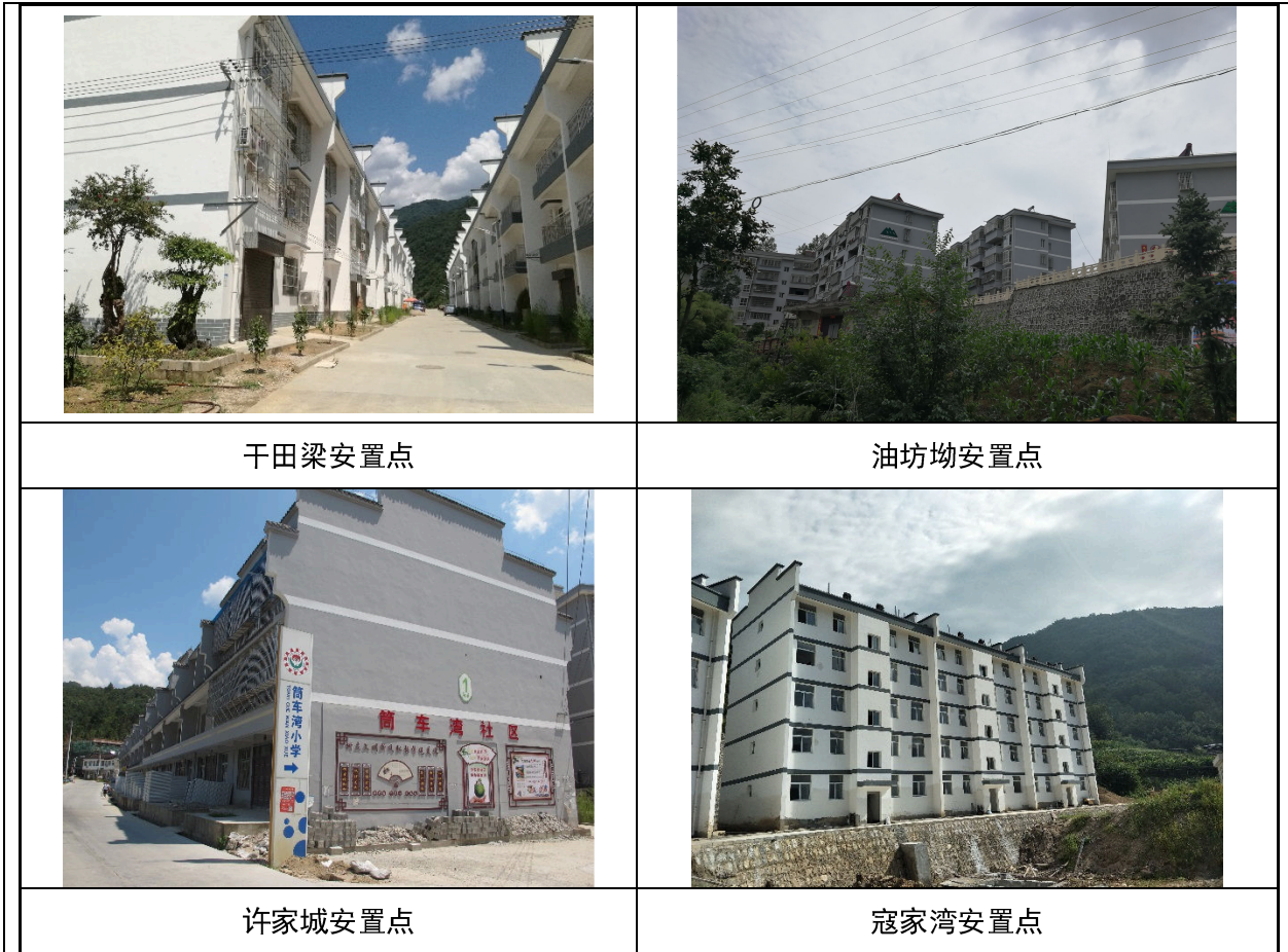
图 1.5-1 已建安置点的现场照片
