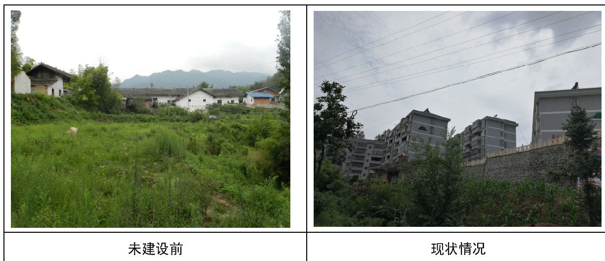
图 2.7-13 油坊坳集中安置点建设前后情况
