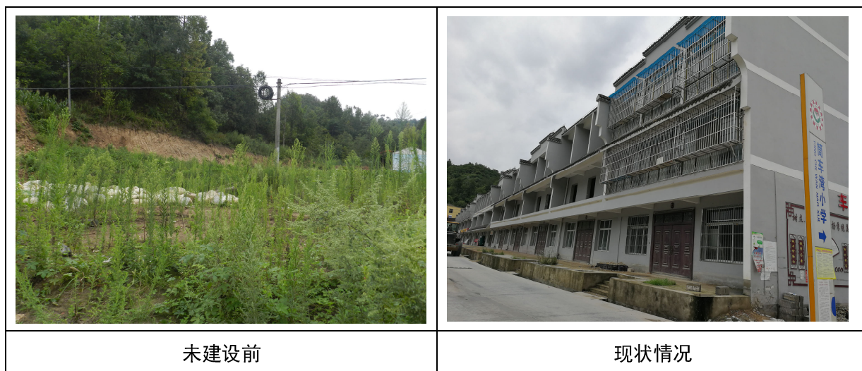
图 2.7-14 许家城集中安置点建设前后情况
