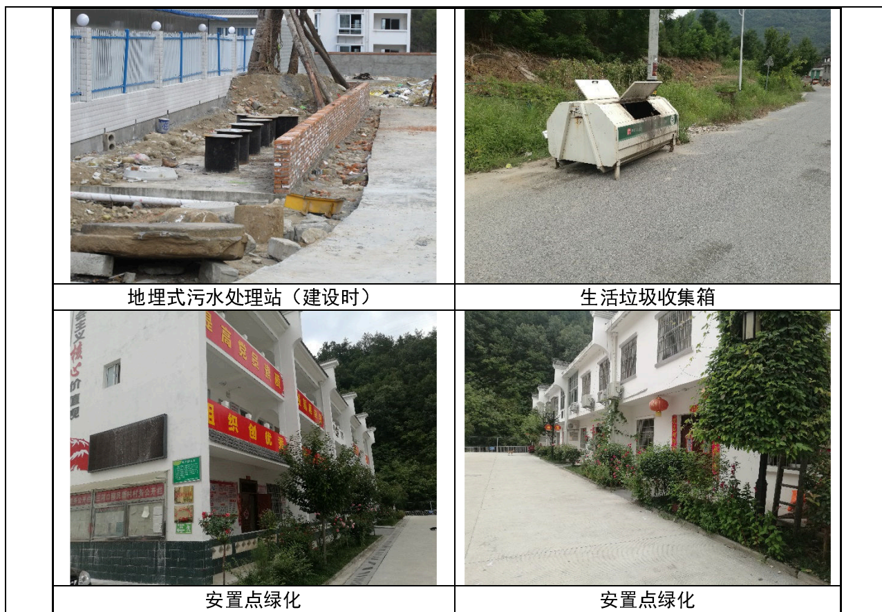
图 5.4-2 马家沟安置点环保措施落实照片
