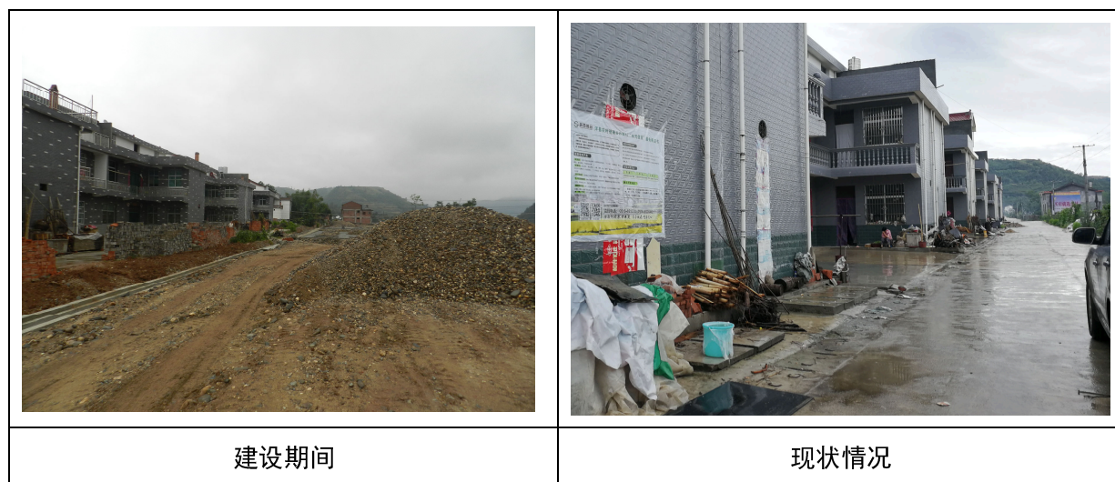
图 2.7-7 万春集中安置点建设前后情况
