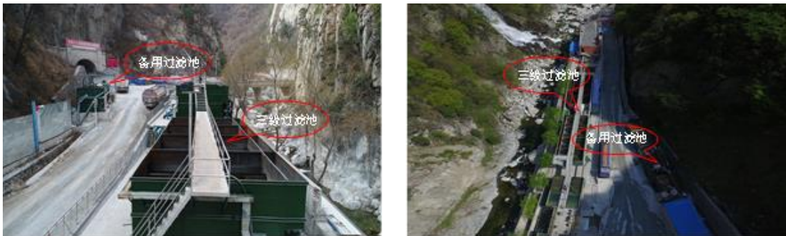
图 6.1-4 高效沉淀池+快滤池+活性炭滤池现场布置图（引汉济渭一期工程）
